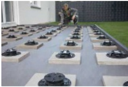
8. Stelle auf jede Platte ein Stelzlager.
